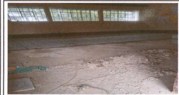
Foto 3: Sustitución de piso de concreto por piso de granito.
