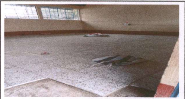
Foto 4: Sustitución de piso de concreto por piso de granito.
