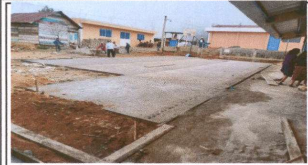
Foto 1: Sustitución de piso de tierra por cemento (patio)
